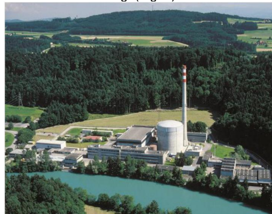
Fig. 1: Luftaufnahme des Kernkraftwerks Mühleberg an der Aare (Foto: BKW FMB Energie AG, https://upload.wikimedia.org/wikipedia/commons/8/87/KernkraftwerkMühleberg.jpg )
